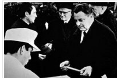
Der Bayerische Ministerpräsident Franz-Josef Strauss legte 1967 den Grundstein für den ersten Bau des Deutschen Raumfahrtkontrollzentrums. Das Gebäude (133) entstand in drei Bauphasen.
